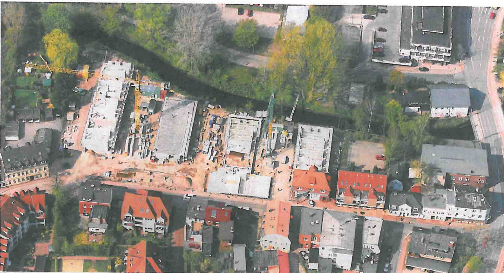
Blick auf Pinnebergs größte Baustelle: An der Koppelstraße entstehen für 18 Millionen Euro sechs Baukörper mit 117 Apartments. LORENZ & PARTNER/FALCONCREST
